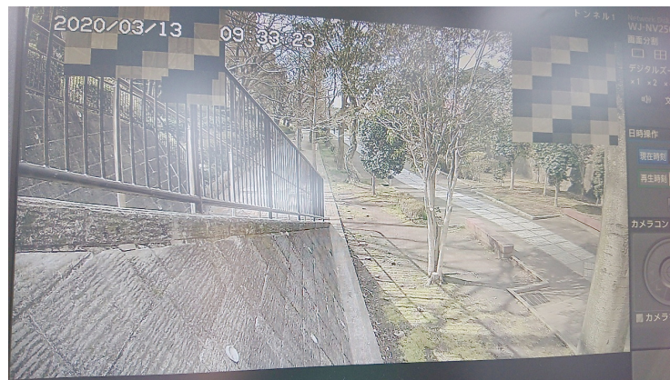
四季の径 トンネル 緑園都市方面
