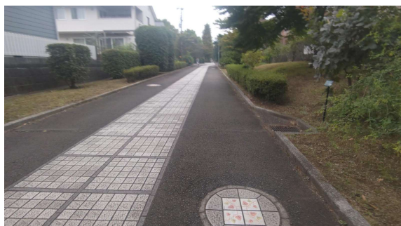
9月に草刈りを実施 (泉土木が実施の中間期)
