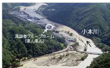
小本川周辺の浸水状況
