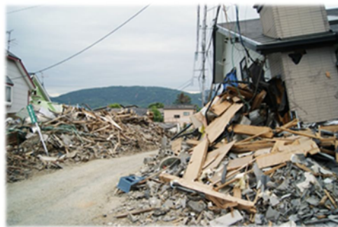
倒壊した家屋
