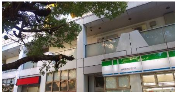
駅西口防犯カメラ樹木剪定(RCA依頼分)
