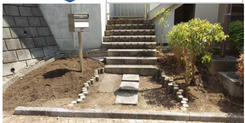
西口出口準備作業完了
