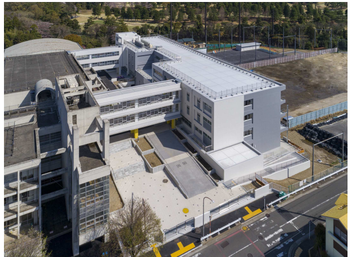
新校舎全景。南西の方向から撮影
